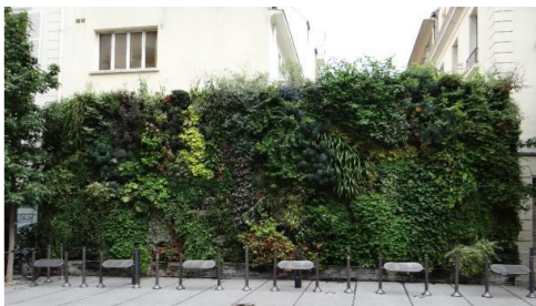
Mur végétal avenue de Wagram Source : Natural Grass
